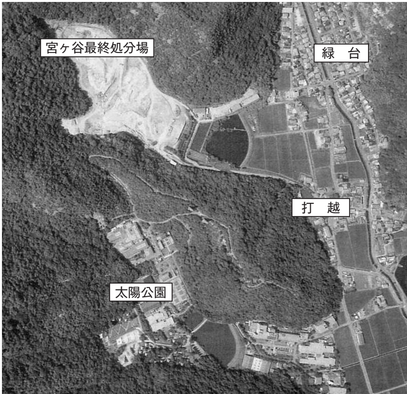
違法行為が次々と明らかになる宮ヶ谷最終処分場航空写真
