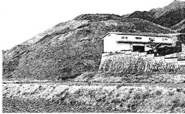
遺物より高くなるか高く積み上げられた土砂 葛城市平岡
